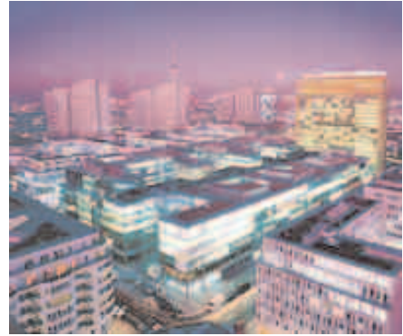
Die Berliner Verlagszentrale der Axel Springer AG
